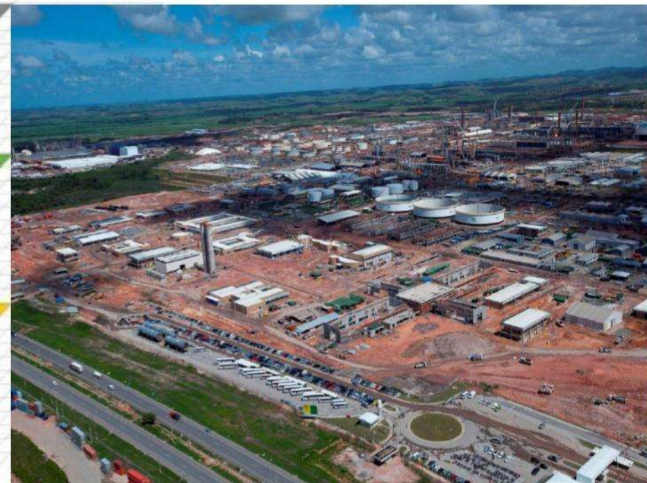
Construção da RNEST no Complexo Industrial Portuário de Suape (PE) mai/12
