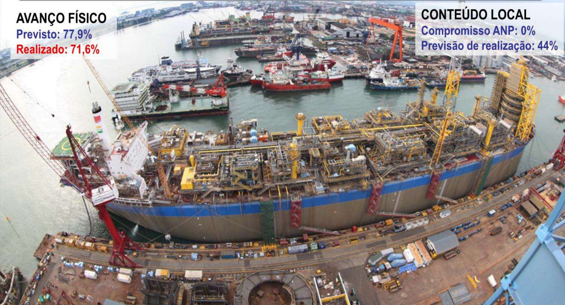
Vista aérea do FPSO cidade de Anchieta no estaleiro Keppel Shipyard, em Cingapura – Mar/2012
